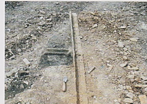
Tramroad plates and sill (2017) Platiau a silliau'r dramffordd (2017)
